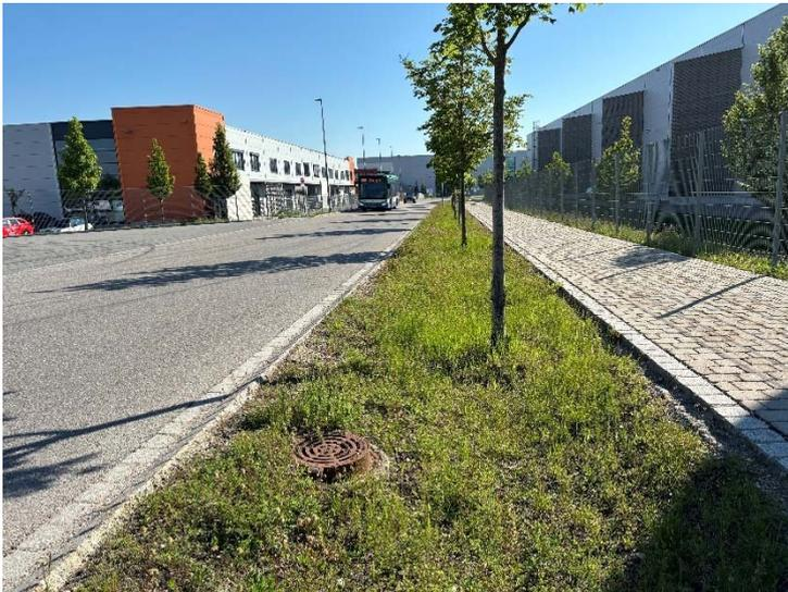
Die straßenbegleitenden Versickerungsmulden werden durch Grundstückszufahrten bzw. Straßeneinmündungen unterbrochen und dadurch in Abschnitte unterteilt. Auf Grundlage des Arbeitsblattes DWA-A 138 Tab. 3 werden die Versickerungsmulden deshalb als dezentrale Versickerungsanlagen eingestuft. Gemäß Tabelle 3 wird eine Bemessungshäufigkeit  $n = 0,2 \text{ a}^{-1}$  (alle 5 Jahre) empfohlen.
