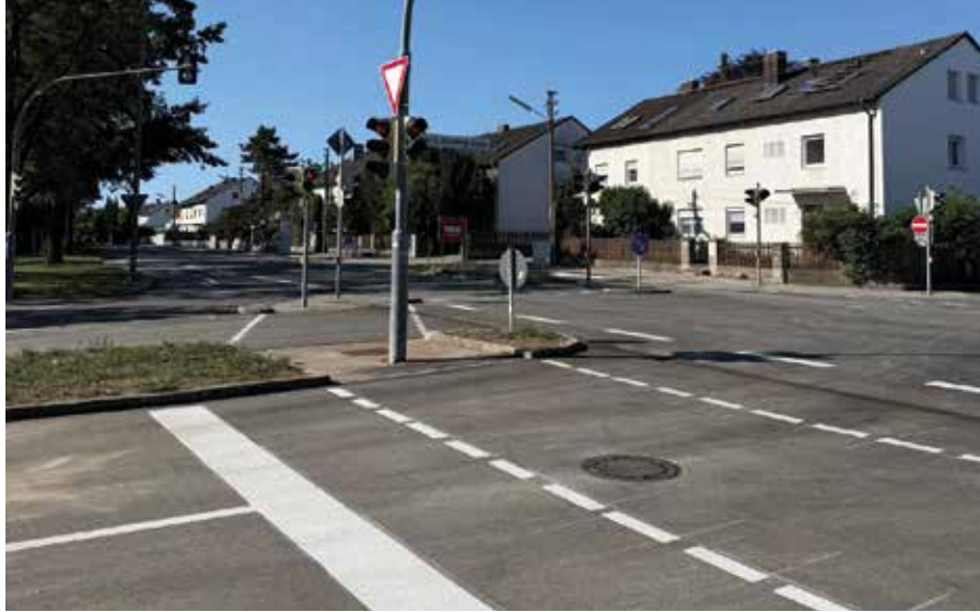
Der sanierte Abschnitt der Roggensteiner Straße.
