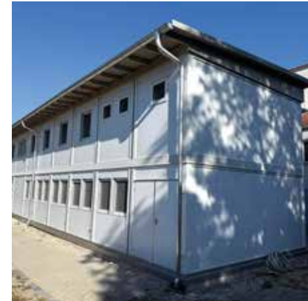
Die fertige zweigeschossige Containeranlage im rückwärtigen Tiefhof.
