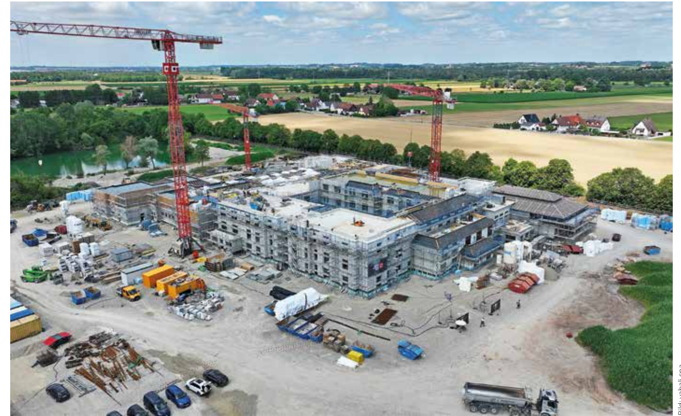
Die Baustelle des zukünftigen vabali spa im Juli 2026 aus der Luft.
