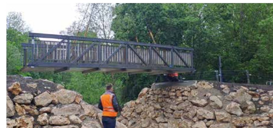
Die neue Brücke wird eingehoben.
