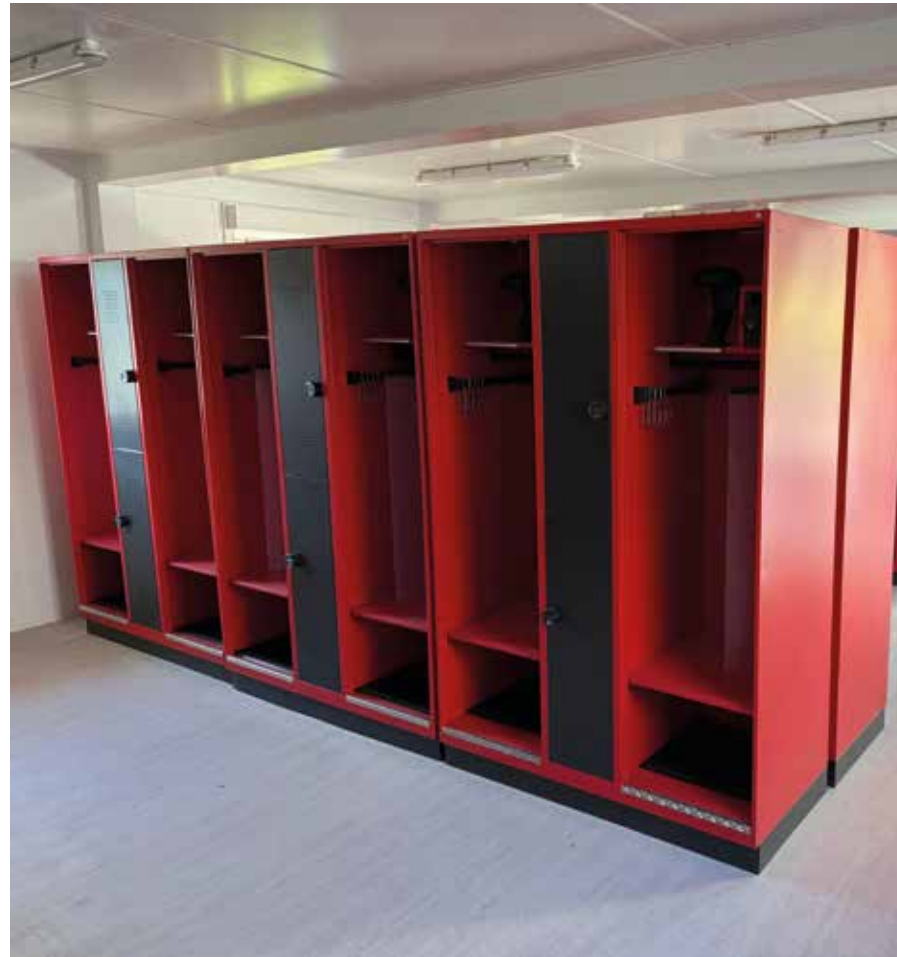
Der neue Umkleidebereich im Obergeschoss des Neubaus.
